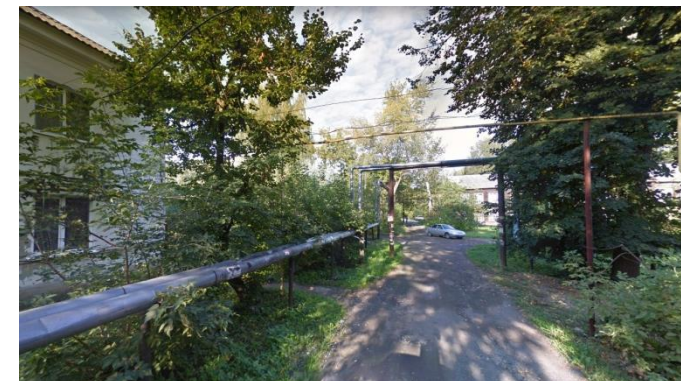
Открытая прокладка инженерных коммуникаций
