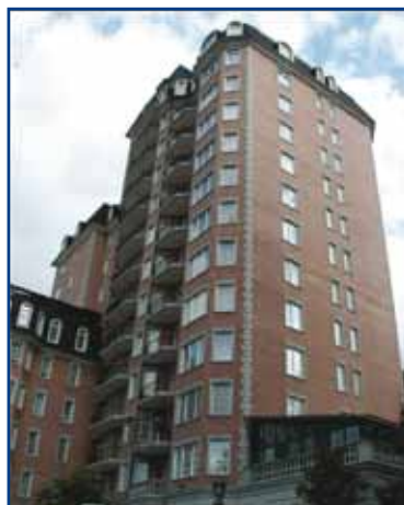
Объект из одинарного полнотелого рифленого кирпича М-250
