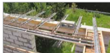
Рис. 5 Устройство балкона в составе перекрытия МАРКО-ПРОФИЛЬ
