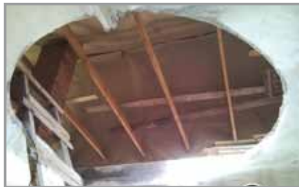
Рис. 11. Круглый проем в перекрытии
