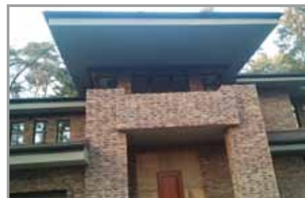
Рис. 12 Козырек входной группы этого дома выполнен на основе перекрытий МАРКО-ПРОФИЛЬ
