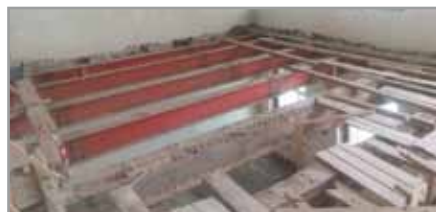
Рис. 2 Стыковка балок сталебетонных перекрытий при реконструкции объекта
