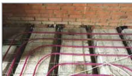
Рис. 9. Прокладке водяного теплого пола в перекрытиях МАРКО
