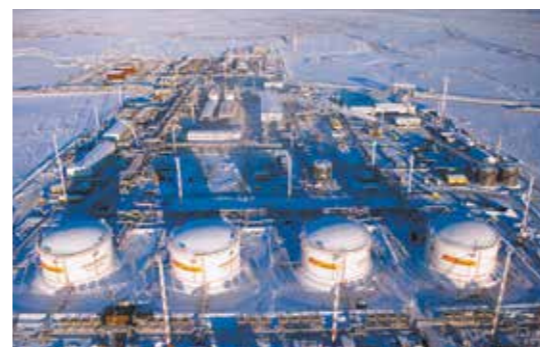
Ванкорское месторождение. УПСВ-Север
